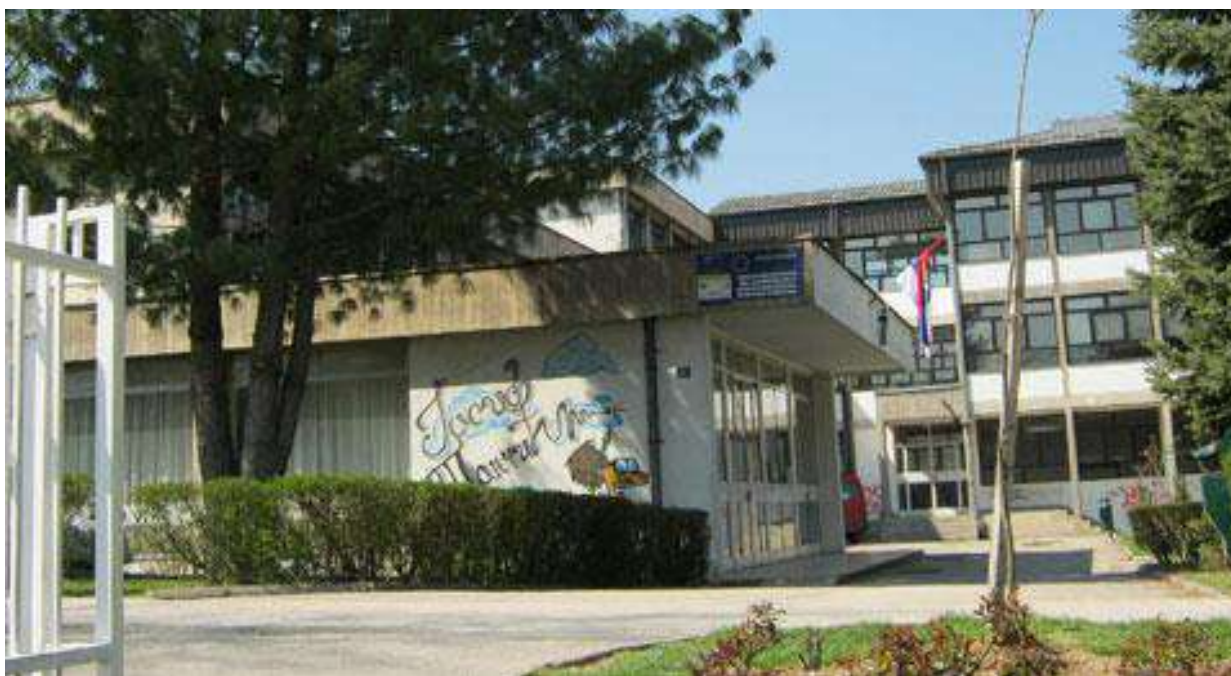
Слика 1 Објекат Техничке школа Бајина Башта
