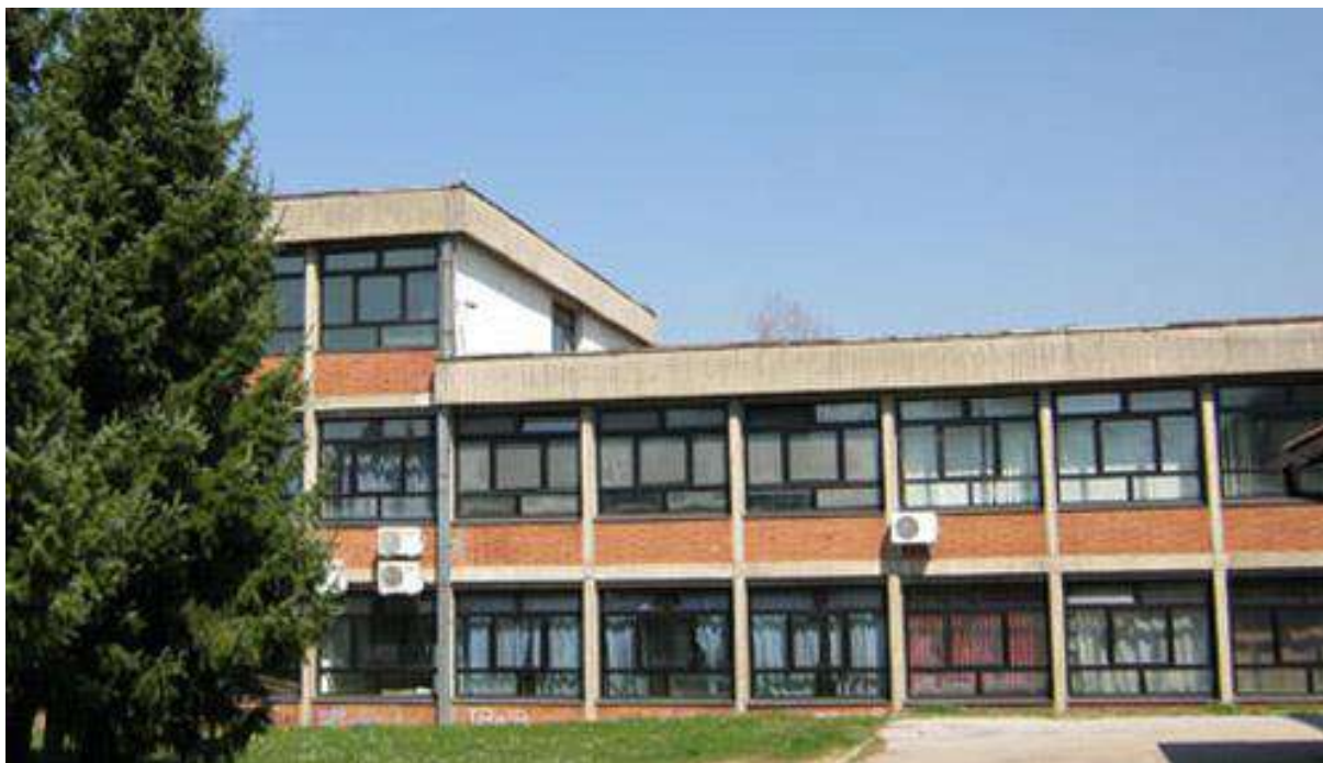
Слика 2 Објекат Техничке школа Бајина Башта
